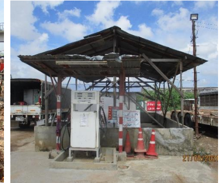
เทพื้นคอนกรีตยกขอบบริเวณที่เก็บน้ำมัน
