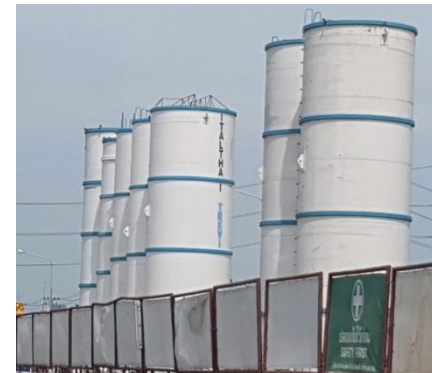
ใช้ Polymer เป็นสารละลายขุดดิน
